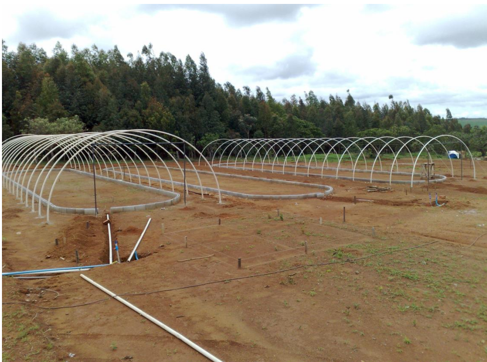
Les trois bassins que je n'ai pu finir avant mon retour en Europe car le film recouvrant la serre n'était pas encore arrivé. Le sol sera recouvert de plaques de polystyrène de 2cm avant de mettre la géomembrane
