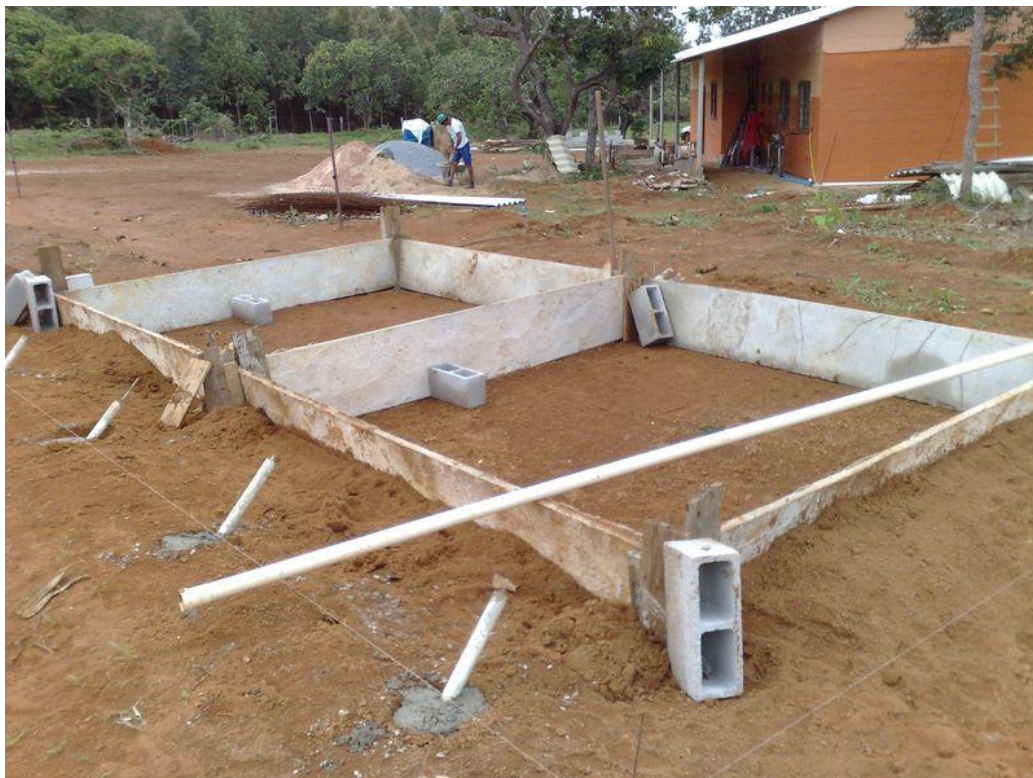
Deux bassins de 3m x 3m pour les souches. Ils sont maintenant presque faits, avec des agitateurs à base de moteurs d'essuie-glace
