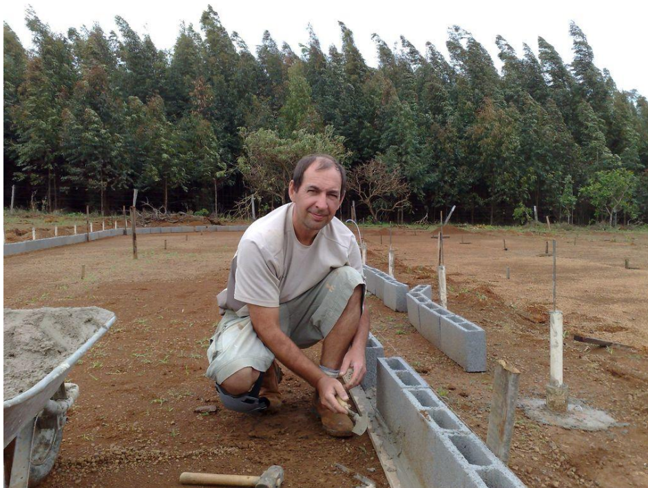
Après avoir nivelé le terrain et installé les plots pour recevoir les tubes PVC de serre, je fait le muret autour des bassins.
