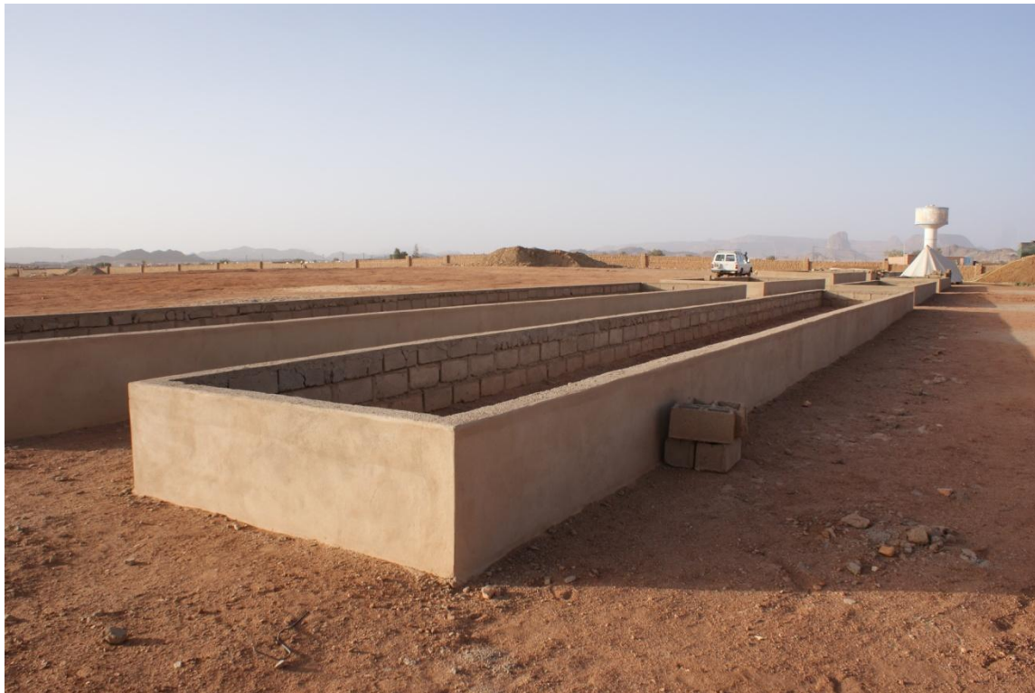
Sur ce site : construction de 7 bassins de 20m 2 , prochainement en fonctionnement.
